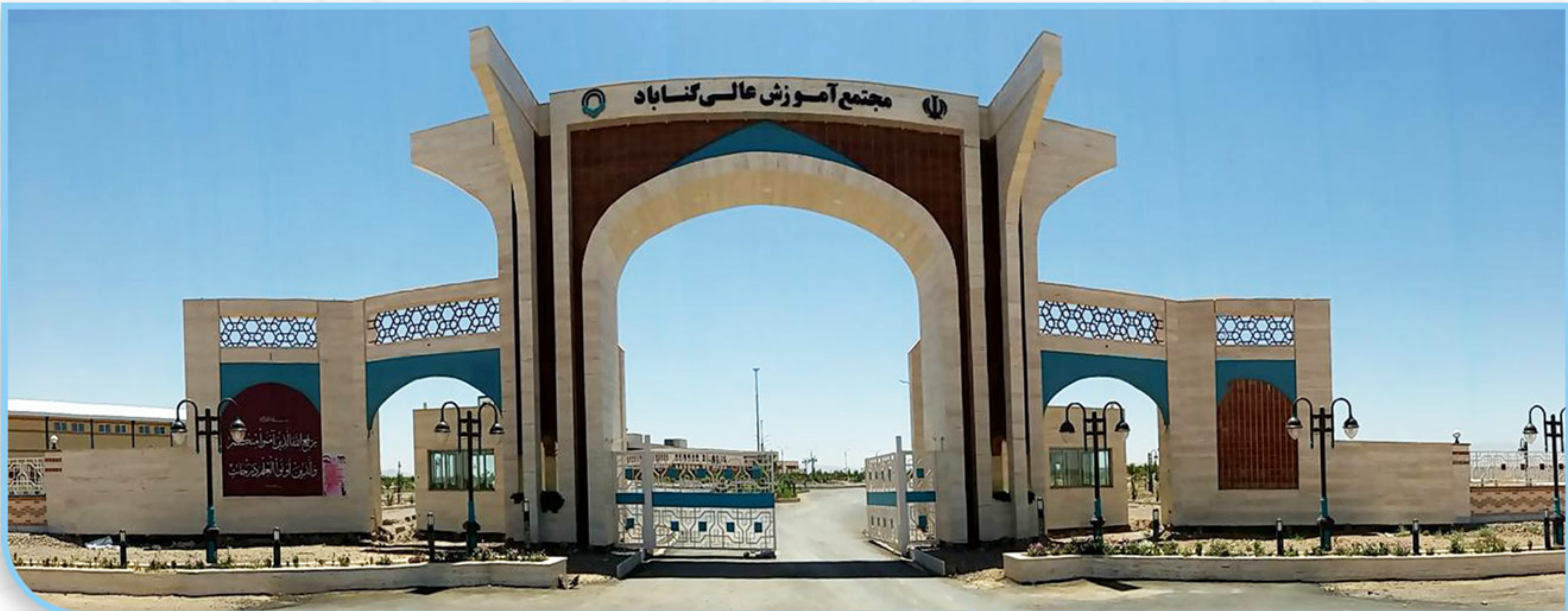
مجتمع آموزش عالی گناباد، فروش، نصب و راه اندازی چهار دستگاه چیلر تراکمی هواخنک ۱۰۰ تن تبرید
