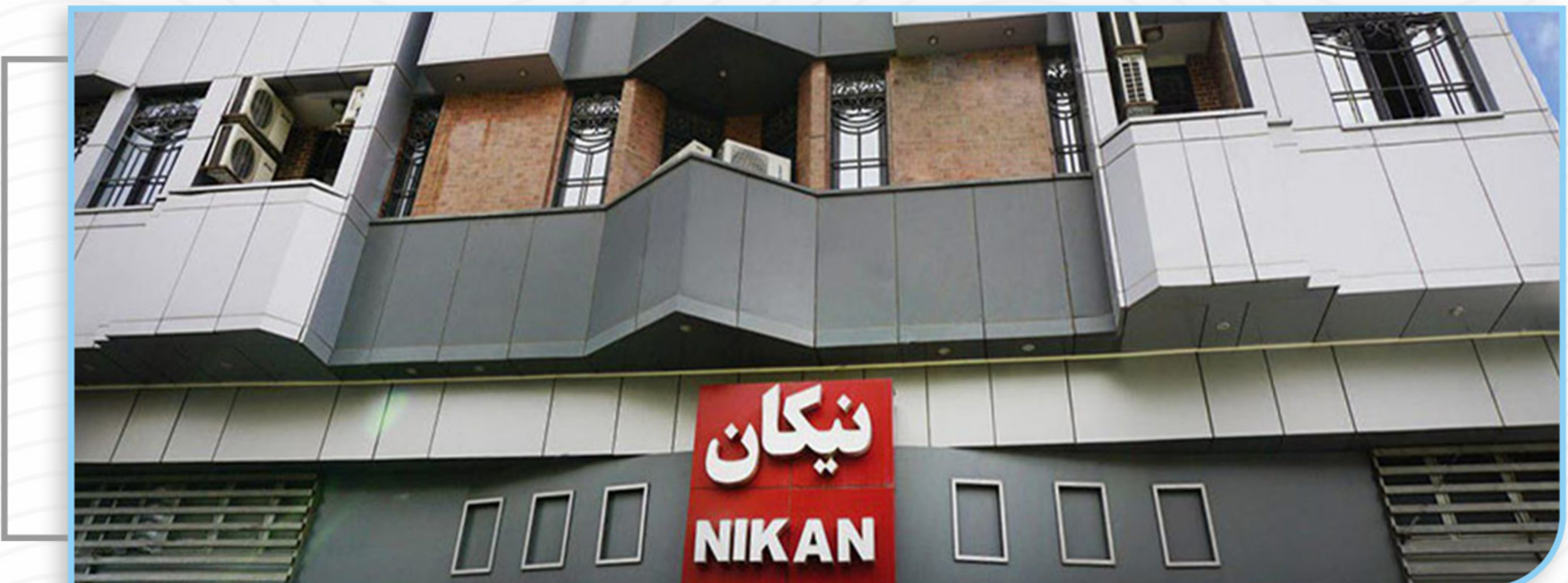
هتل نیکان، مشهد خیابان دانش غربی، فروش، نصب و راه اندازی دو دستگاه دیگ آبگرم و کلیه تجهیزات موتورخانه
