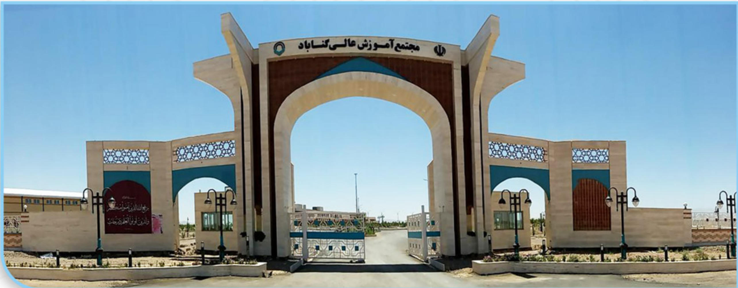
مجمع آموزش عالی گناباد، فروش، نصب و راه اندازی چهار دستگاه چیلر تراکمی هواخنک ۱۰۰ تن تبرید
